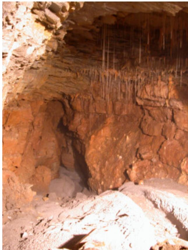
Abb.4: Erster Hohlraum West mit Betonverfüllung
