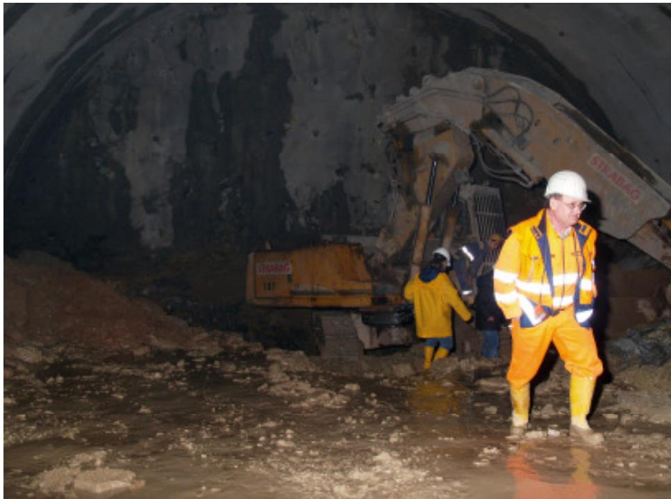
Abb.1: Tunnel mit Ortsbrust, der Bagger steht auf dem Sprengschutt, der den Zugang zum Ostteil der Höhle versperrt. Rechts unterhalb der Zugang zum Westteil, Aufnahme: Dieter Weiß, 02.04.08
